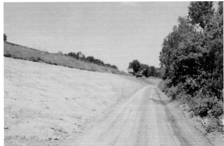
Abdichtung Straßendamm B 9
