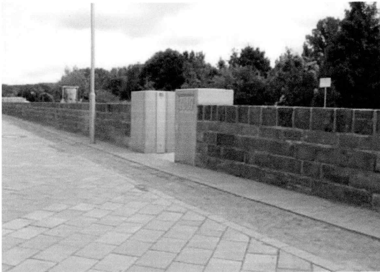
Sanierte Hochwasserschutzwand
