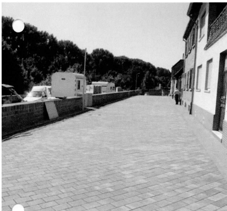
Gepflasterter Straßenabschnitt Rheinstraße
