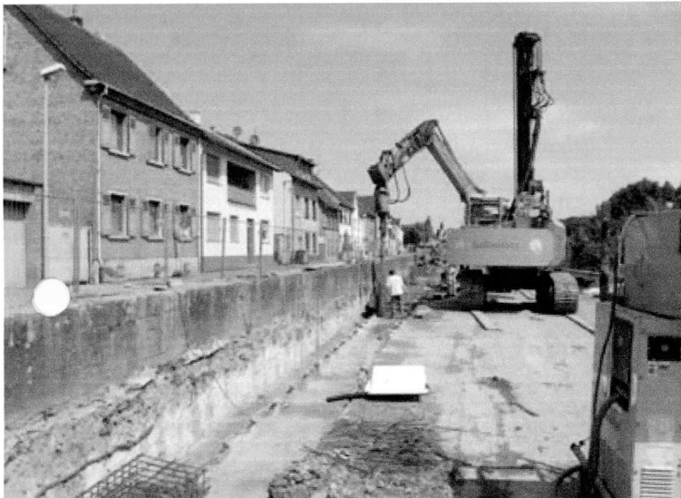
Untergrundabdichtung Hochwasserschutzmauer
